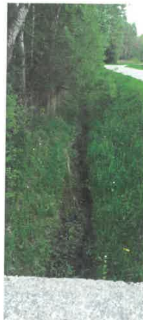
Rys. 1 Rów opaskowy składowiska „Pióry”
